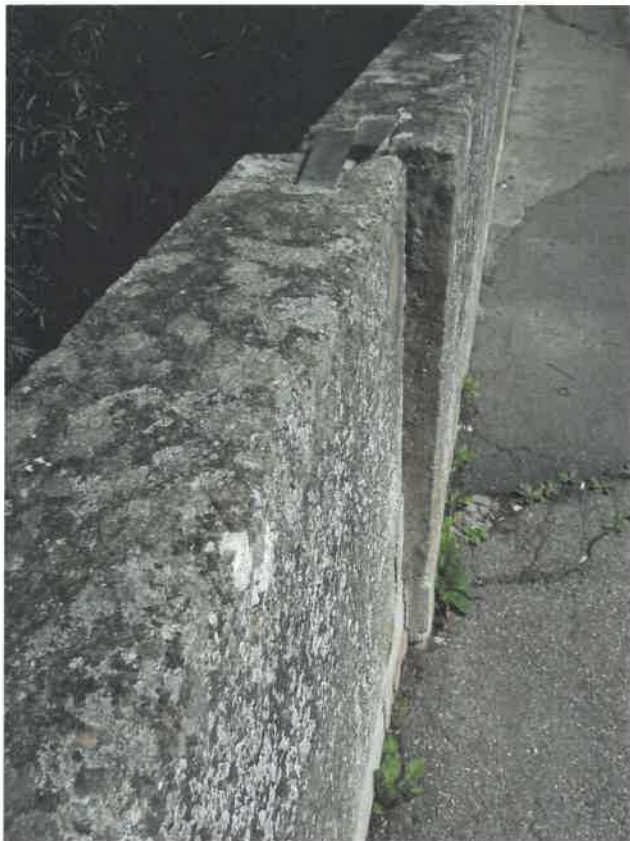
Foto 10 Detail Brüstungsmauer Nord
